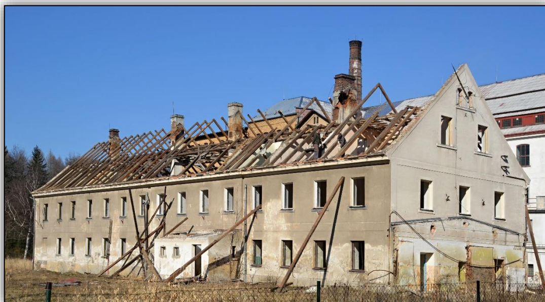
Obr. 6. Frýdlant č. p. 35 (LB), vodní mlýn Höllemlühle. Demolice objektu. (foto I. Peřina, 2014)
