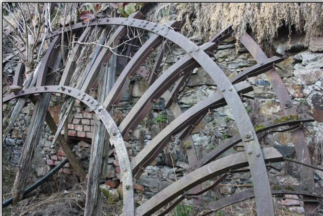
Obr. 7. Zříceniny Zechmühle u Stříbra, bývalé čp. 476 (TC). Zbytky kovové konstrukce vodního kola. (foto Z. Procházka 2012)
