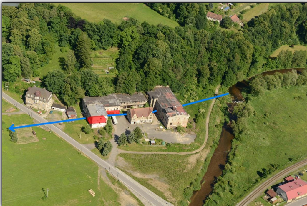
Obr. 12. Poustka č. p. 25 (LB), niťárna a barevna, původně vodní mlýn a pila. Modře je vyznačena trasa náhonu od torza jezu v řečišti Smědé. Červeně zdivo přízemí mlýna, začleněné do stavby niťárny, v popředí červeně vyznačeno místa, kde stála vodní pila. (foto A. Tauchman, 2017)
