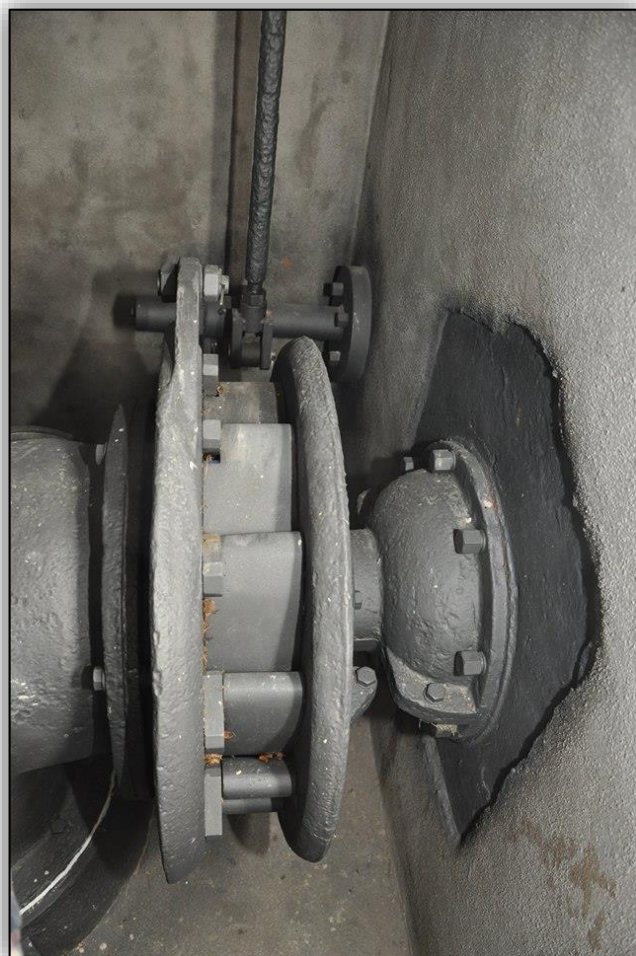
Obr. 8. Detail rozvadčících lopatek, pod nimi je oběžné kolo turbíny. (foto D. Veverka, 2017)
