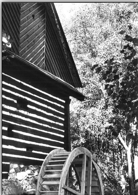
Obr. 2. Králova Pila č. p. 15 (CR), vodní mlýn a pila „jednuška“. Obnova proběhla v letech 1968-1970. (foto L. Štěpán, 1970)
