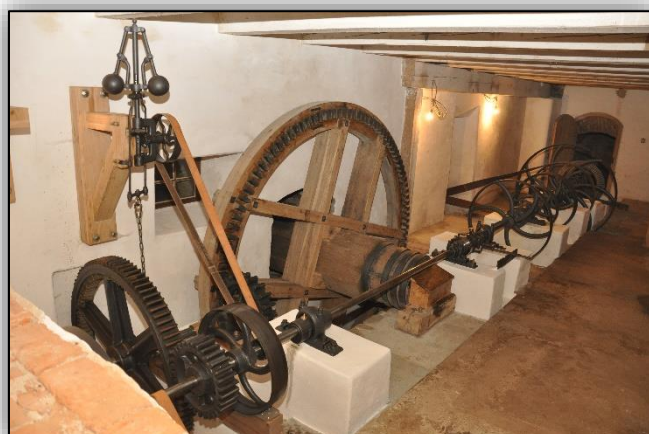
Obr. 12. Převodová výstroj (paleční soukolí boční a čelní předlohové, hlavní transmisse s řemenicemi a kluznými kroužkomaznými ložisky Sellersova typu, zubová posuvná spojka, Wattův kulový odstředivý regulátor s třecí brzdou k pojistnému brzdění transmisse při překročení kritických otáček). (foto D. Veverka, 2017)
